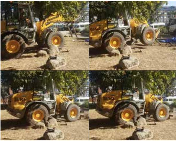
Der Bagger stemmt sich gegen ein altes Betonfundament
